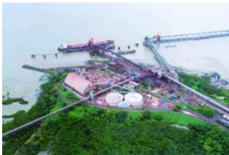
Companhia Vale do Rio Doce: Terminal Marítimo de Ponta da Madeira, onde estão localizados três píeres, seis silos de estocagem de grãos, além de uma área para desembarque e armazenamento de ferro-gusa, em São Luís/MA
